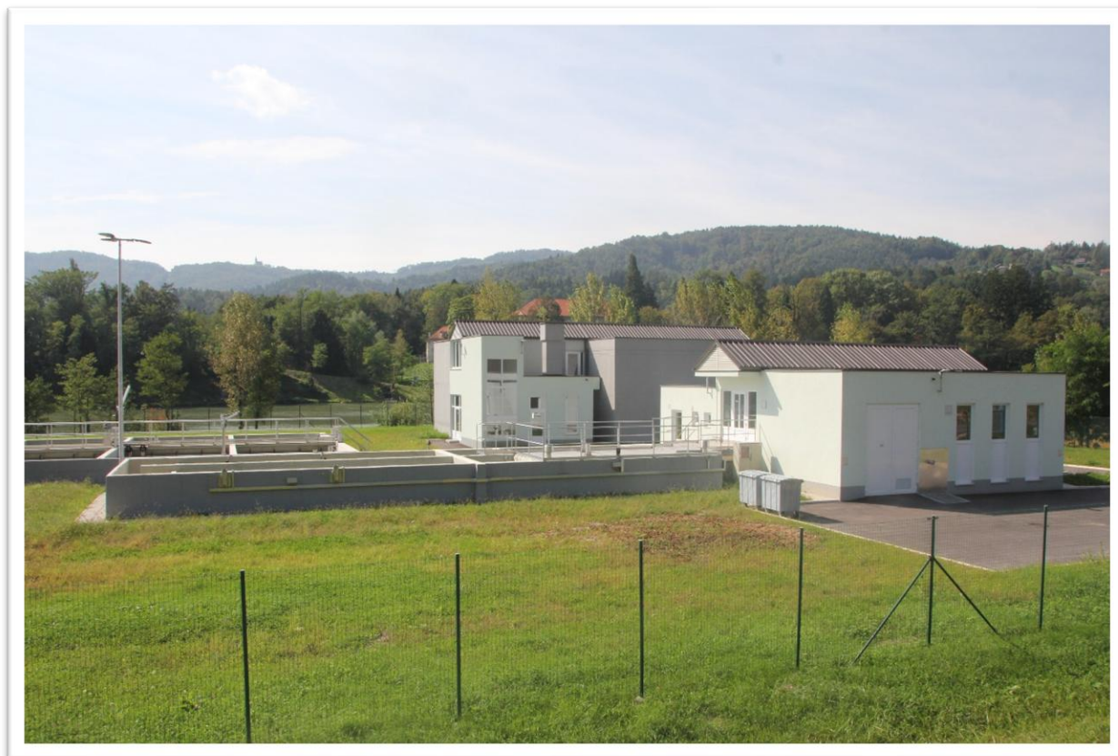
Slika 1: Centralna čistilna naprava Radeče
