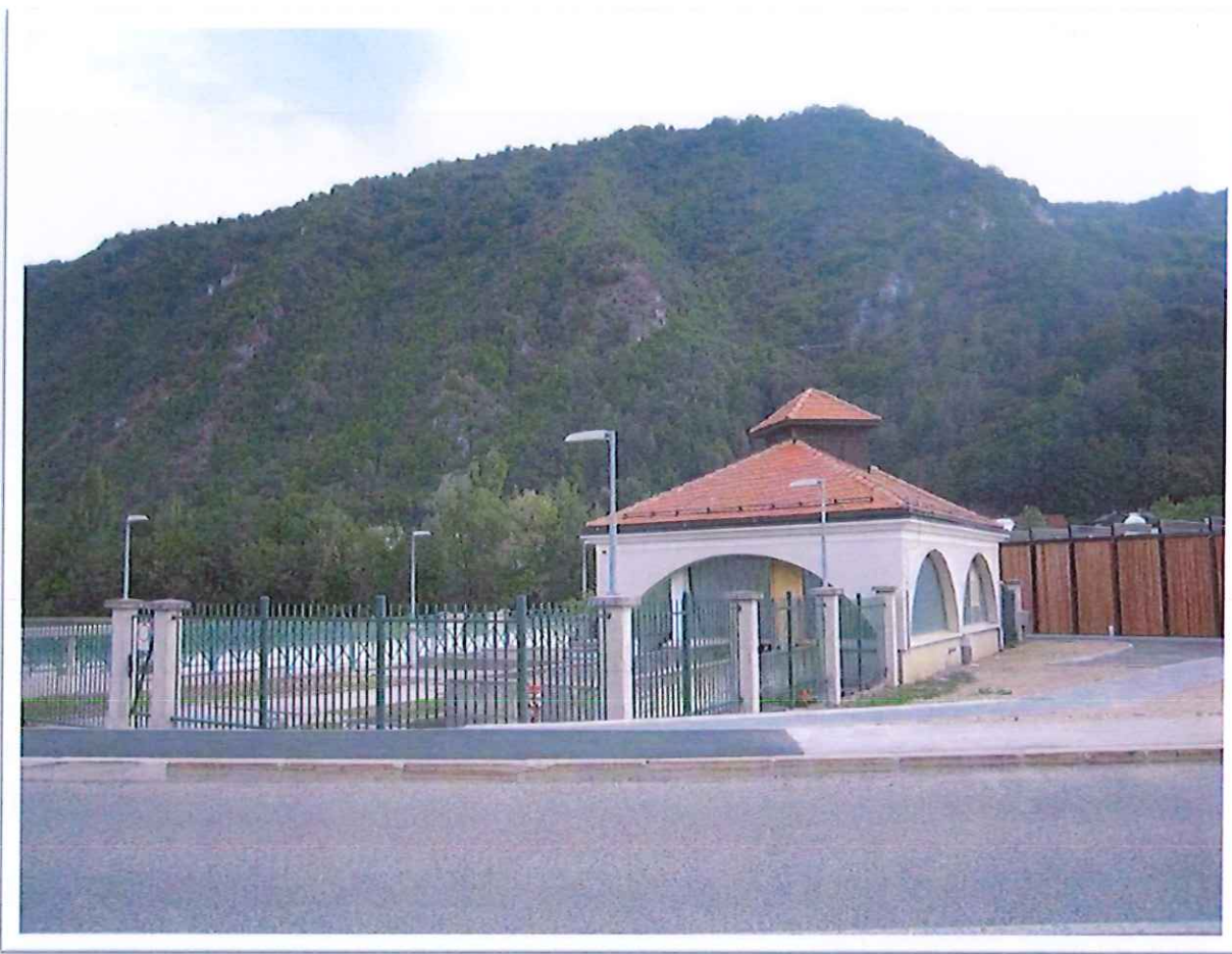
Slika 1: Črpališče fekalnih vod Radeče
