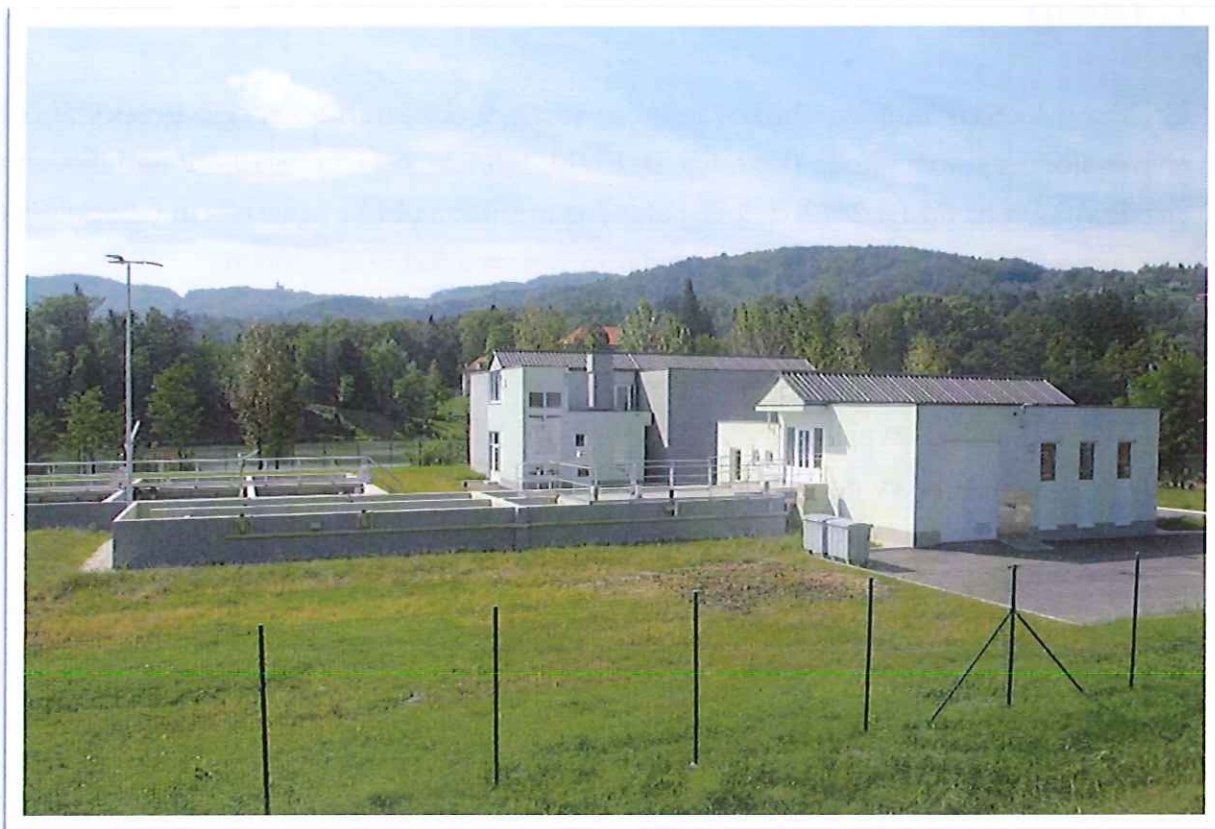
Slika 1: Centralna čistilna naprava Radeče
