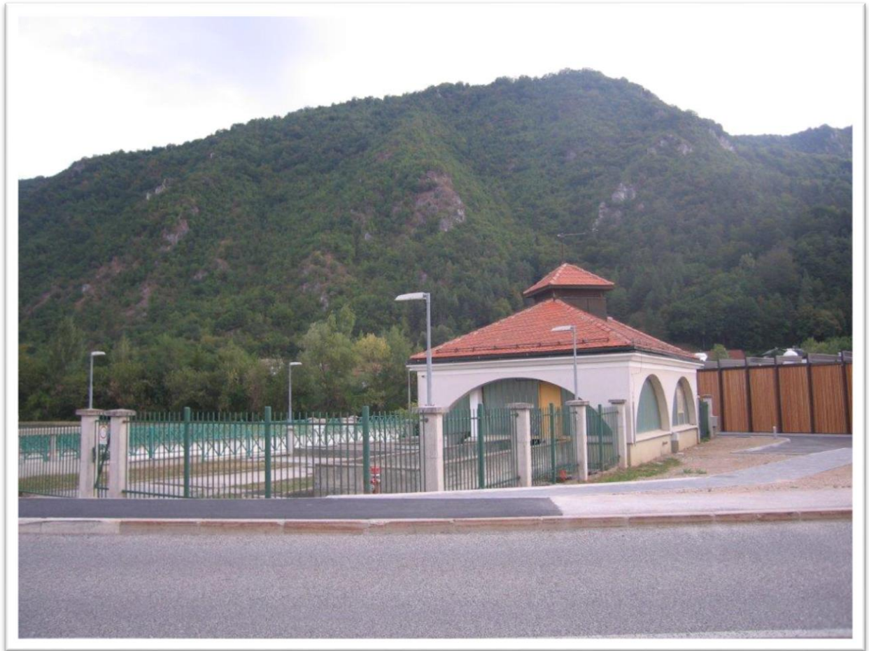
Slika 1: Črpališče fekalnih vod Radeče
