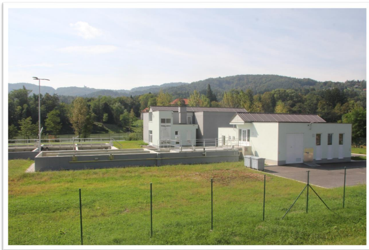
Slika 1: Centralna čistilna naprava Radeče
