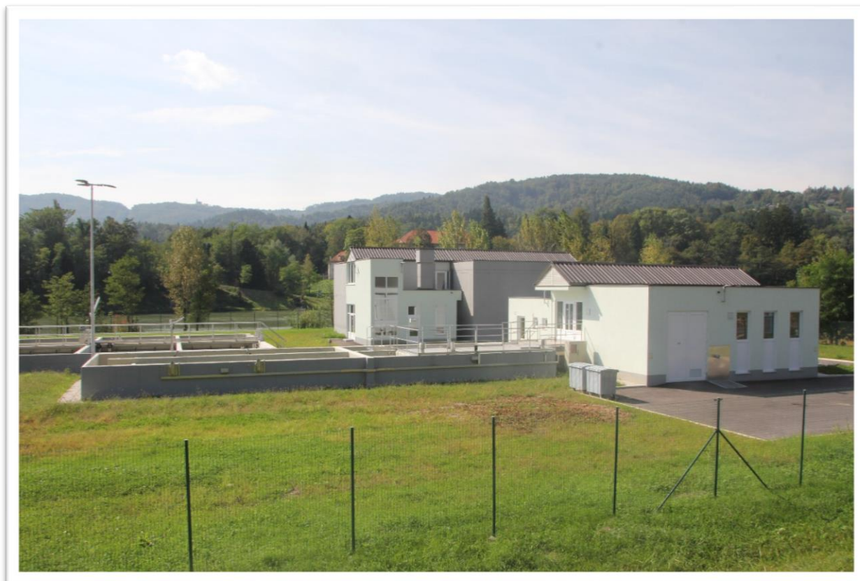
Slika 1: Centralna čistilna naprava Radeče
