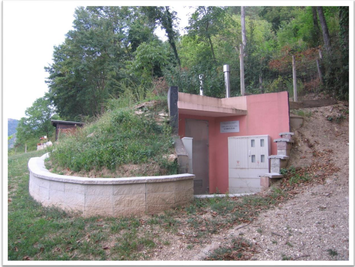
Slika 2: Črpališče na vodovodu Obrežje, ki se napaja iz vodovoda Radeče
