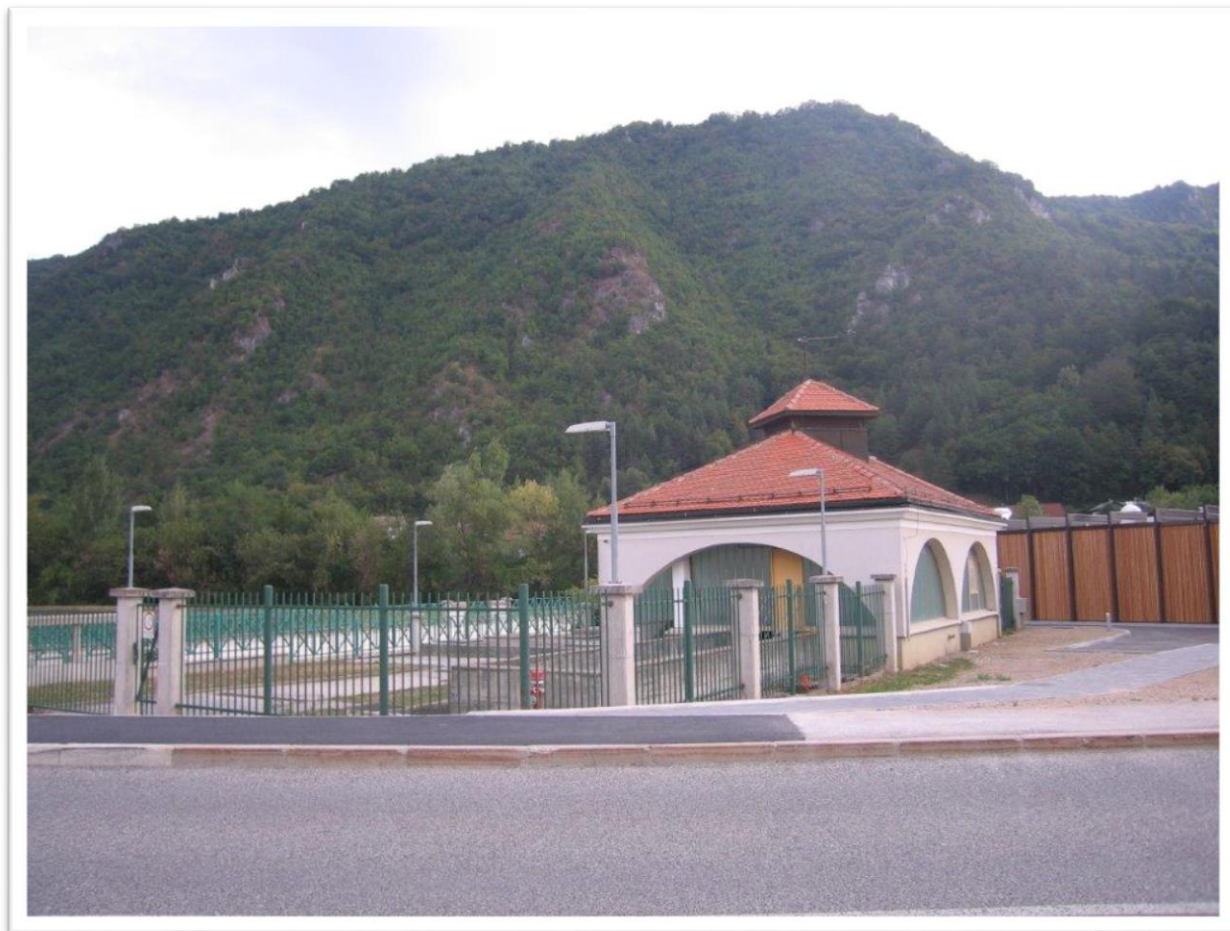
Slika 1: Črpališče fekalnih vod Radeče
